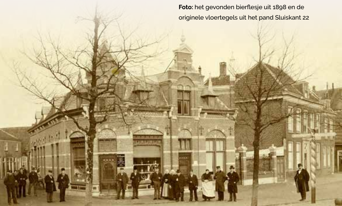
Foto: fotocollectie mevrouw van Kooperen zicht op de sluis kant met het nieuwe pand aan de Sluiskant anno 1900
